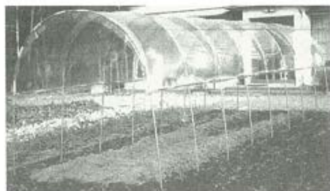
組立完成写真
