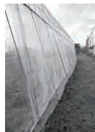
巻き上げパイプ取り付け
