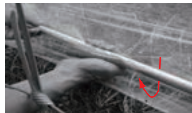
ビニールを外側より、巻きつけてパッカーを取り付ける。
