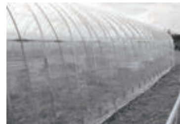
パッカーで、枠を囲うように、横、下側を留めていきます。
