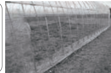
ビニバー取り付け完成
