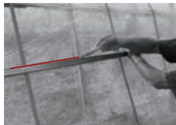
枠取りの線引き時に、ビニバーを利用すると、書きやすいです。
