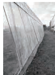
巻き上げパイプ取り付け
