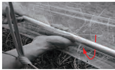
ビニールを外側より、巻きつけてパッカーを取りつける。
