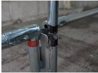
黒色の印がある柱のパイプ差し込み箇所へ黒色の印がある桁を差し込む。
