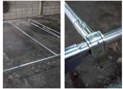
補助桁は桁へのせるだけで OK。
