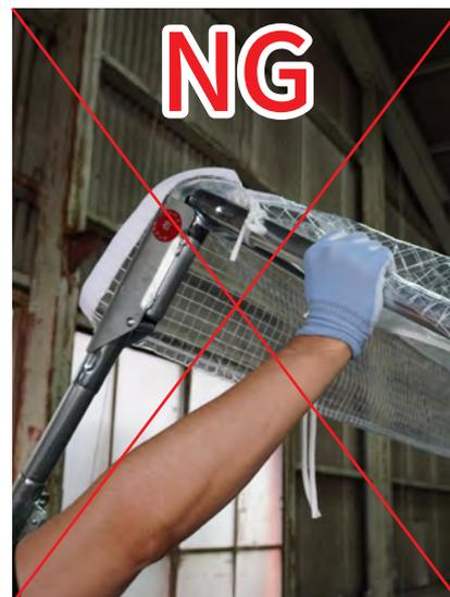
片側の柱をおこします。その際、桁を持つと柱から抜けて危険な為、持たないように気をつけておこします。
