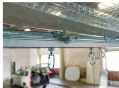
パイプバンド付ブラケットをカーテンレールの溝へ引っ掛けてレールを押し込めば取付完了となります。
