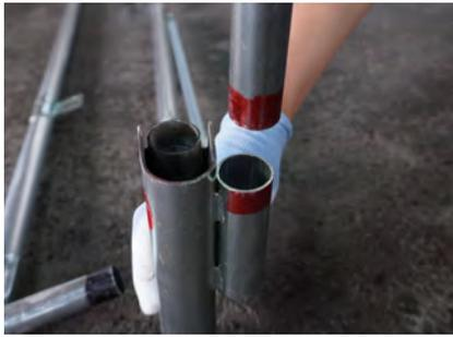
赤色の印がある柱のパイプ差し込み箇所へ赤色の印がある桁を差し込む。
