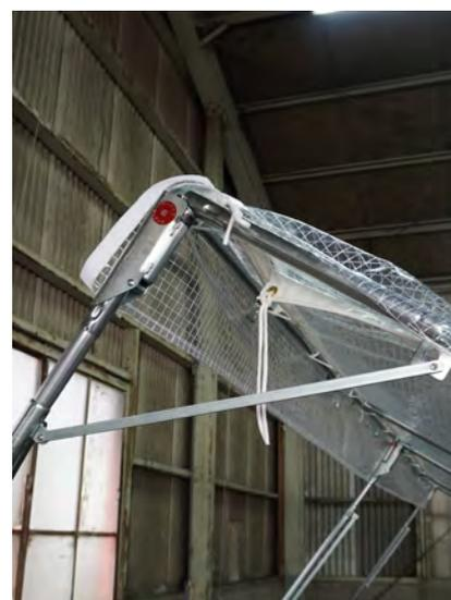
片側の柱をおこしたら柱の方杖を桁へ固定させます。そうする事により柱から桁パイプの抜け落ちを防止できます。
