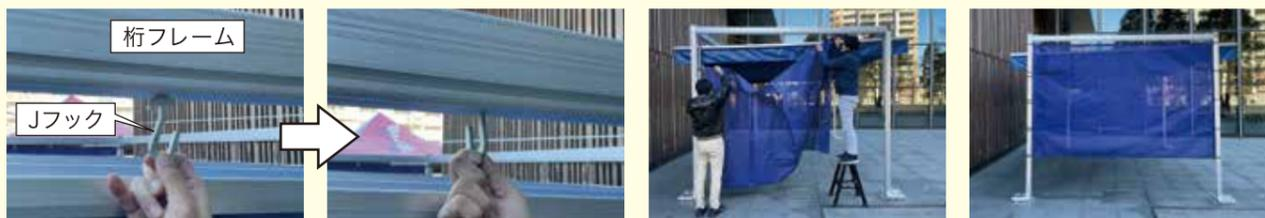
付属のJフックを側面桁フレームのレール部に等間隔で取り付けます。差し込み、90度回転させると固定されます。そのあと、横幕上部のハトメに先ほど取り付けしたJフックに取り付けます。両サイドのマジックテープを柱に固定してください。
