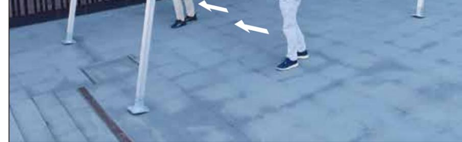
片側の柱フレームを伸ばしたら、逆の柱を伸ばすため、天幕を伸ばし終わった柱側へ移動させ固定します。
