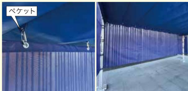
横幕上部のハトメに付属のOフックを取り付けます。天幕水下側のポケットにOフックを取り付けていきます。最後に両サイドのマジックテープを柱に固定してください。
