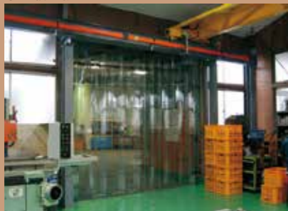
※P16 施工事例と併せてご参照ください。
