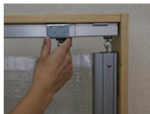
②カバーをずらして端部のレールを外す。
