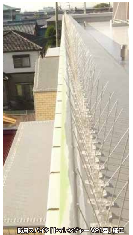
防鳥スパイク「トマレンジャーV21型」施工
