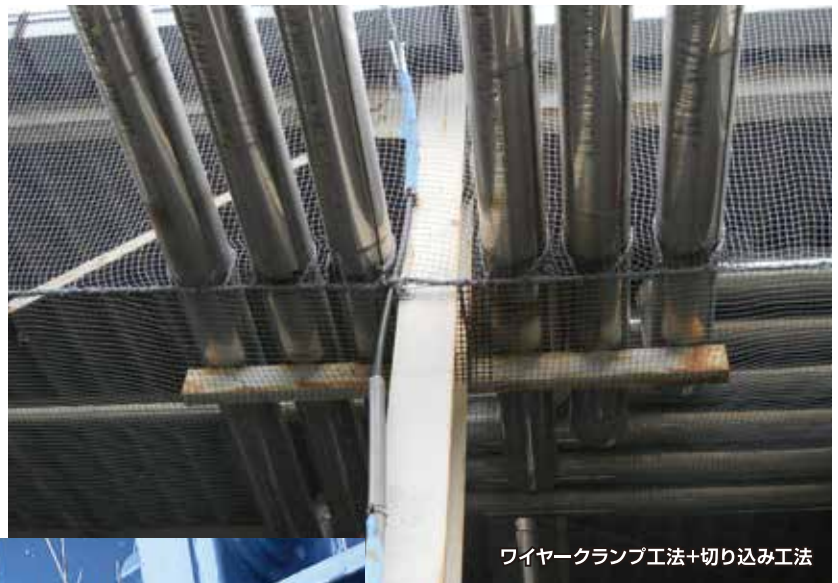
マンション吹抜けの防鳥に/ アンカー&ワイヤー工法（一部脱着式）
