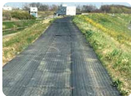
河川専用道路 重機搬入養生
