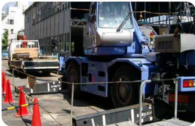
駅舎工事現場
