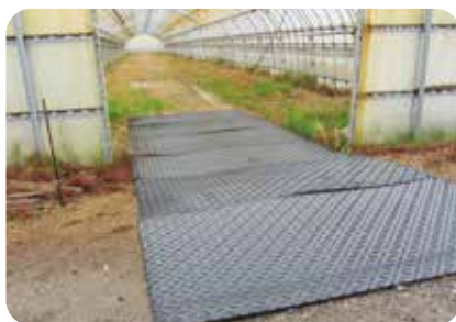
ビニールハウス出入口養生
