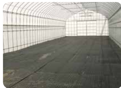
大型ビニールハウス全面養生
