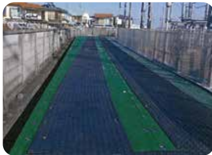
電力会社 変電所通路養生
