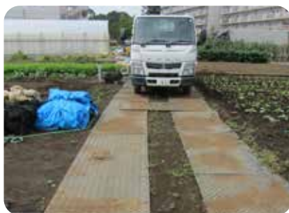
畑内路面養生
