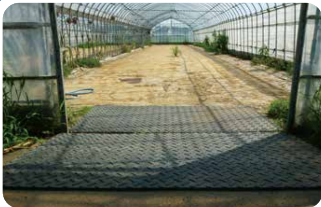
ビニールハウス入口養生
