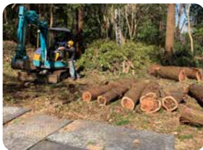
林道 足場養生
