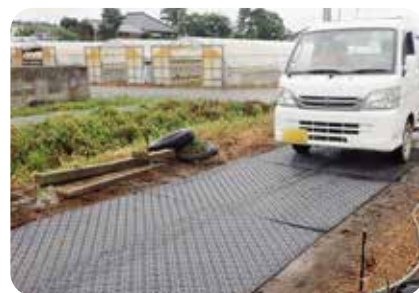
トラックの通路養生
