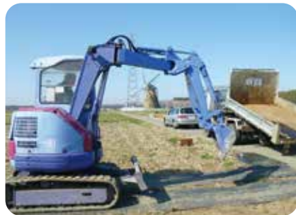
乾田内通路養生
