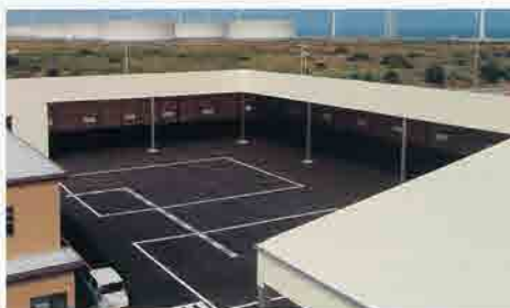
施工例：工場荷捌き場
