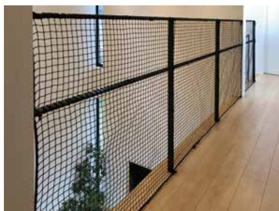
階段手すりネット取付例
