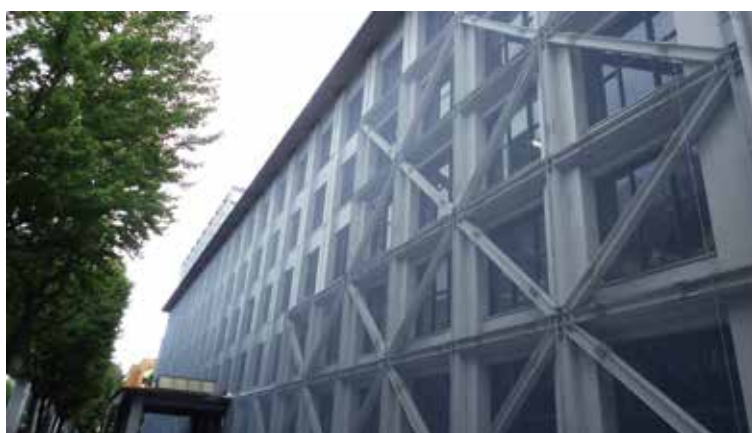
剥落防護ネット取付例
