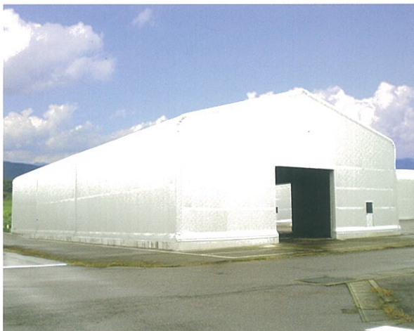
施工例：テント倉庫
