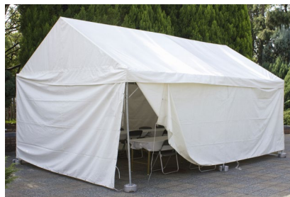
テント施工時の固定・補強
