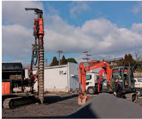
土地の地盤が軟弱な場合、時間の経過とともに地盤沈下を起こしてしまうため改良して地盤を締め固めます。
