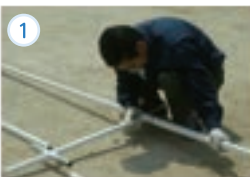
1 骨組みを組み立てます。
