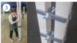
3 専用支柱を立て、テント支柱に連結具で上下2カ所を固定連結します。
