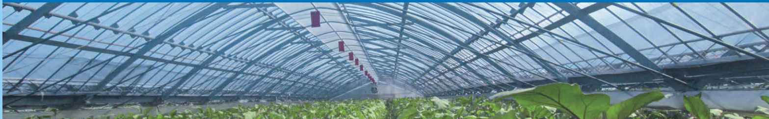
「プラチナコート」を展開した施設園芸ハウス
