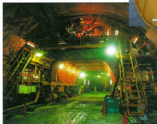
トンネル養生シート
