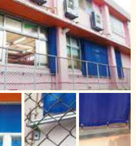
屋上施設 雨風除け 防塵 テントシート、XGレール使用
