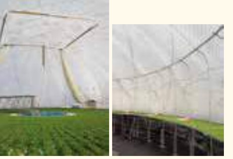
農業ハウス 日除け メッシュシート、D40レール、ベンダーレール使用
