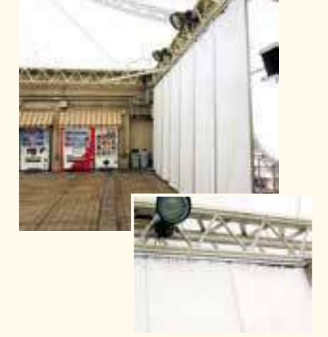
屋上施設 雨風除け 防塵 テントシート、XGレール使用
