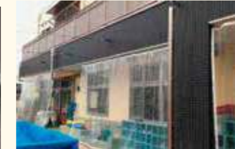
駐輪場 雨・風除け ビニールシート、テントバー使用
