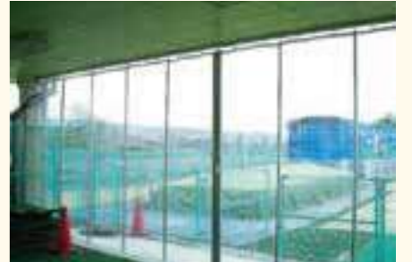
農業ハウス 日除け メッシュシート、D40レール、ベンダーレール使用
