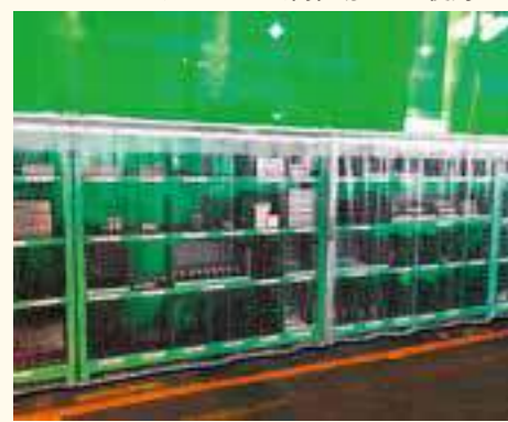
製品棚 防塵 ビニールシート、D30レール、間仕切ポール使用
