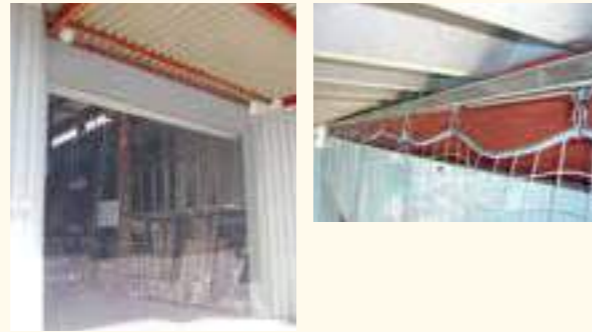
壁にはネットBOXバーで固定 サイドポールにネットBOXバー取付け
