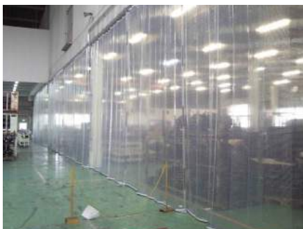
【防塵／空調管理対策】
