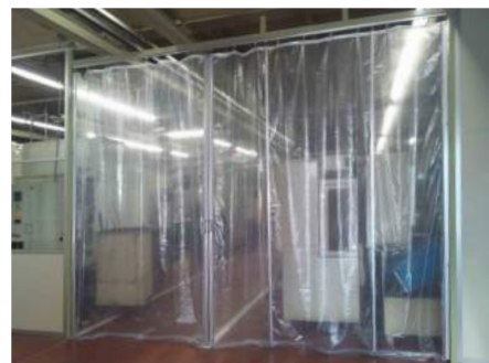
【防塵／空調管理対策】
