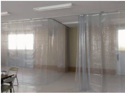
【間仕切り／空調管理対策】
