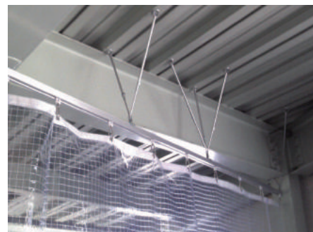
【防煙/間仕切り対策】
