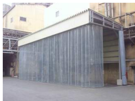
【防雨／防塵対策】
