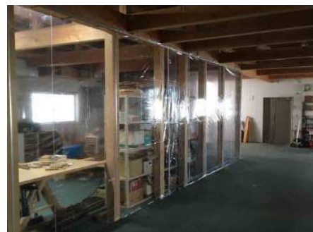
【防塵／防音／空調管理対策】
