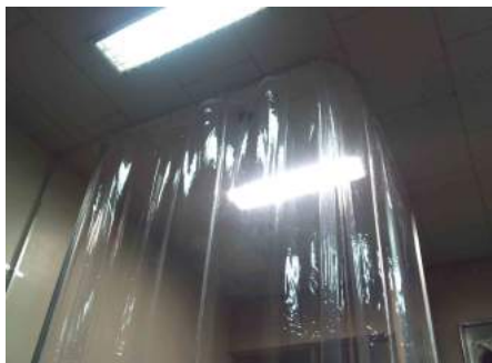
【間仕切り／空調管理対策】
