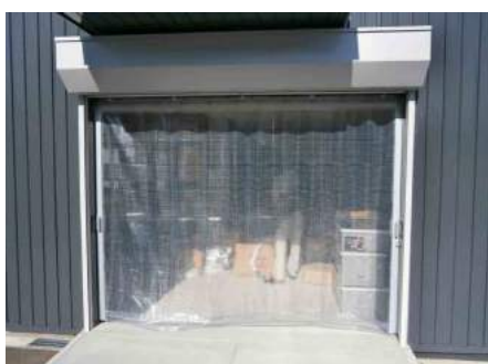
【防塵／空調管理対策】
