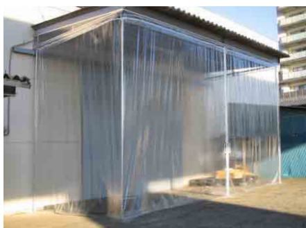
【防雨／防塵対策】
