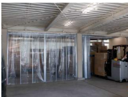
【防塵／空調管理対策】
