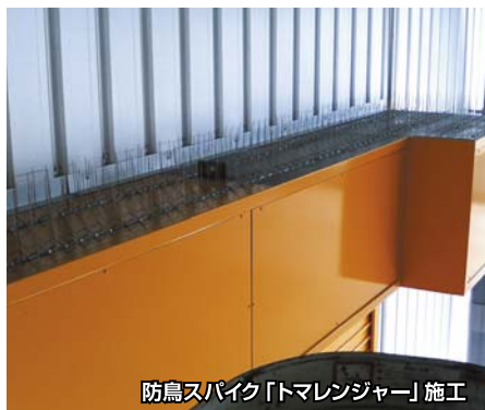
防鳥スパイク「トマレンジャーV21型」施工
