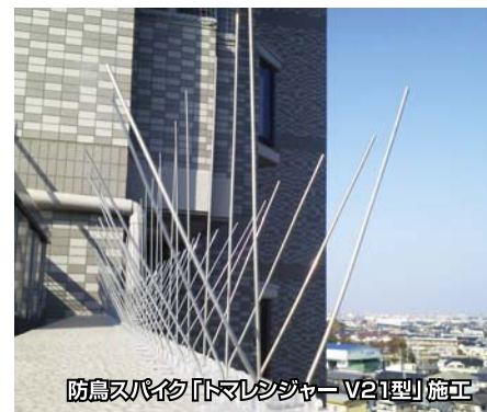
防鳥スパイク「トマレンジャーV21型」施工
